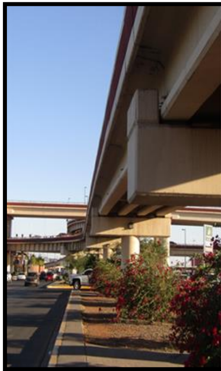
Imagen 30. Distribuidor vial bulevar Luis Encinas y Solidaridad.
