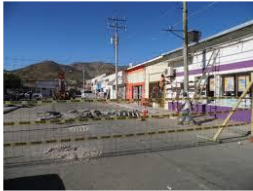
Cambio de fachada y pavimentación
