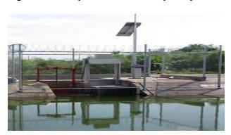
Figura 39. Compuerta hidráulica tipo Slipmeter.
