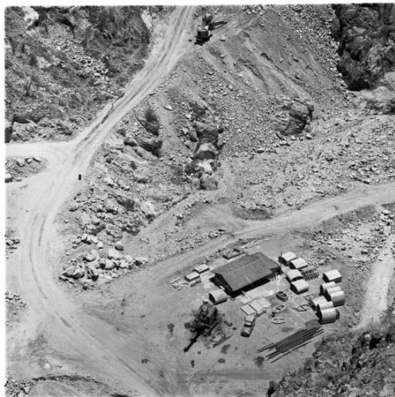
Construcción de caminos en El Novillo.
