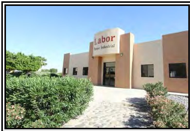
Figura 11. Fachada Parque Industrial Labor
