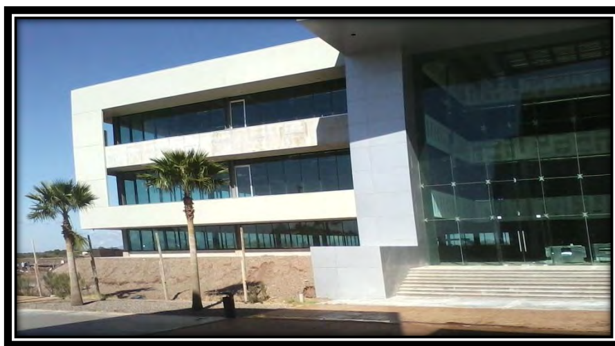
Figura 7. Fachada del Edificio B
