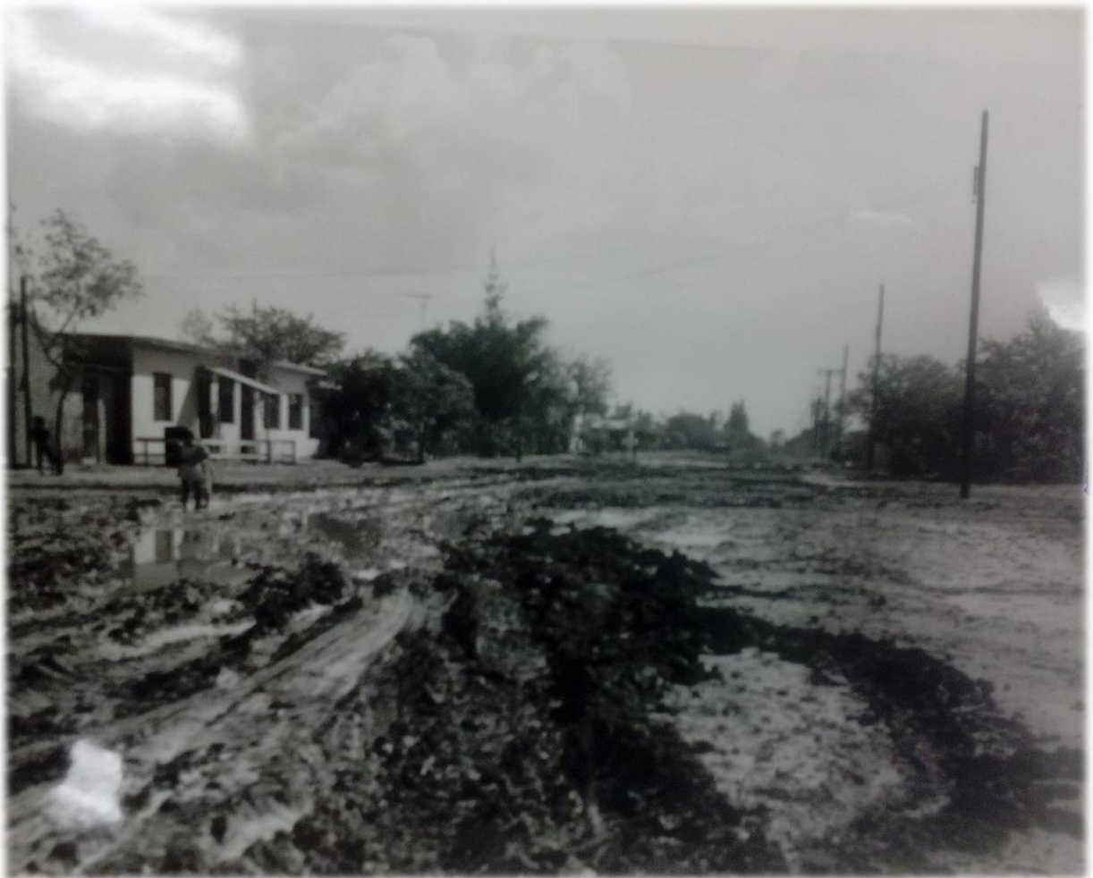
Fotografía 2. Septiembre de 1970. Es notorio el rezago en que se encontraba la calle 5 de febrero, una de las principales vías de Ciudad Obregón. Dicha calle es paralela a la Carretera Federal Núm. 15. Fuente: N. Pastelin (ND/09/1970). Calle 5 de febrero. Nótese la falta de red de agua potable y alcantarillado. Caja 49, Exp. 1133, Año: 1970. Archivo Histórico del Agua. Colección Fotográfica.
