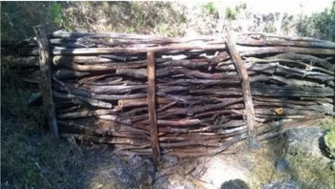
Construcción de presas de ramas.
