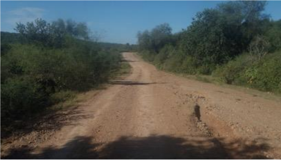
Conservación y mantenimiento de caminos.
