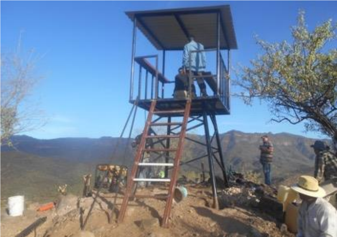
Construcción de torre de vigilancia
