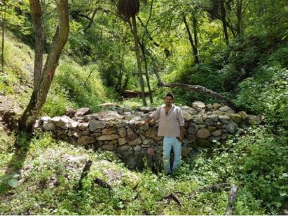
Construcción de presas filtrantes de piedra acomodada.
