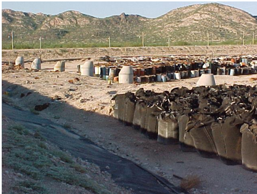
Imagen 2: Vista panorámica de una celda de confinamiento del CYTRAR en la que se puede apreciar los residuos confinados y el liner ó forro de las celdas. Cortesía: César Catalán M.
