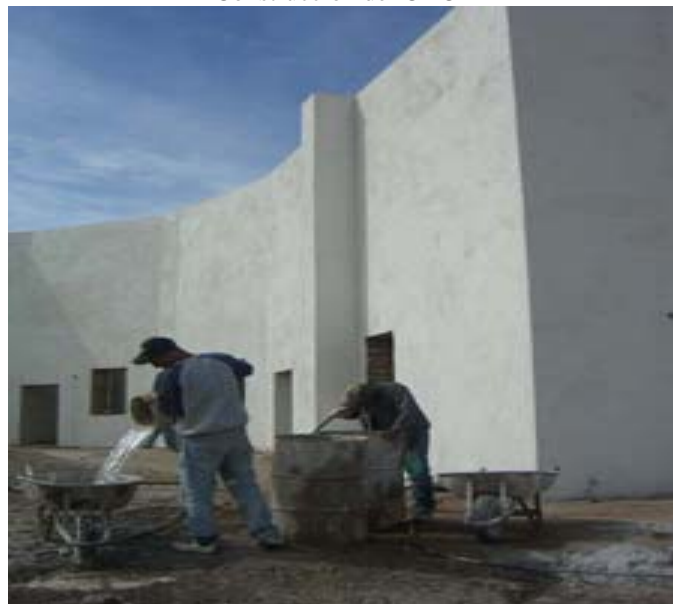
Construcción del CACH
