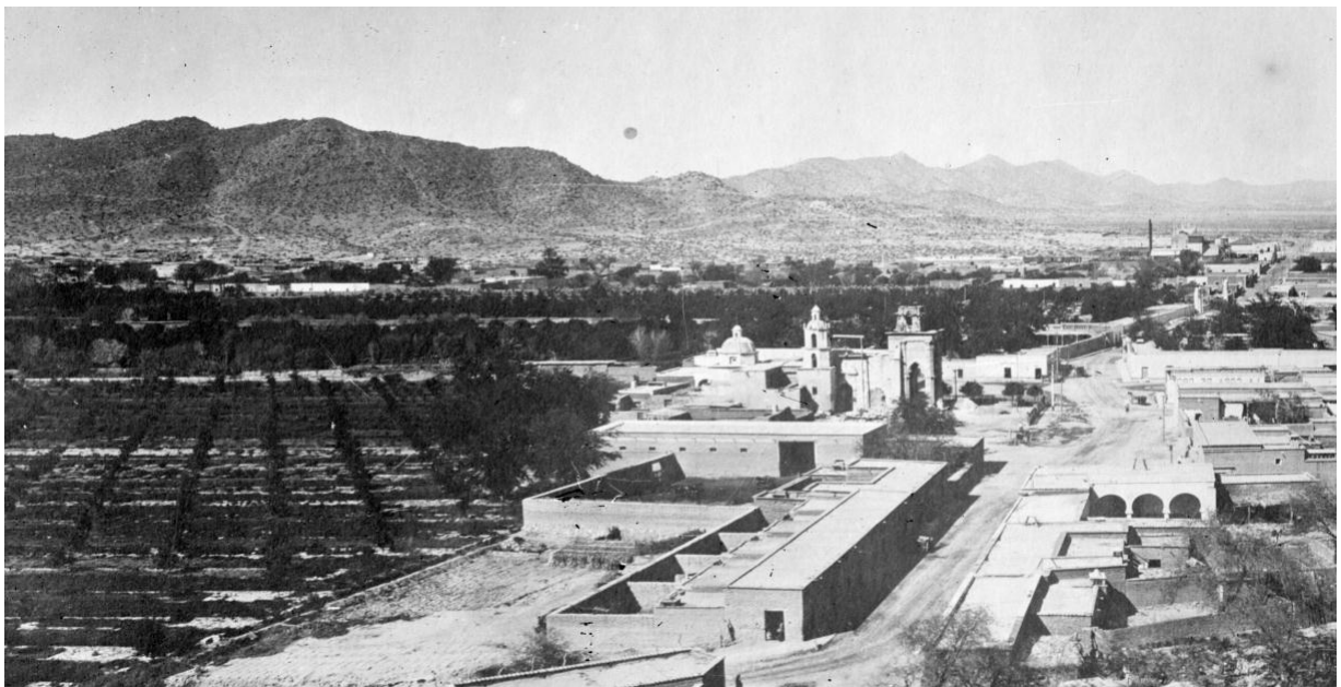
Imagen 21: Panorámica del suroriente de Hermosillo desde el Cerro de la Campana. Fuente. Fototeca INAH, Pachuca (Titulo original: Hermosillo, vista panorámica, Inventario: 82934). 308
