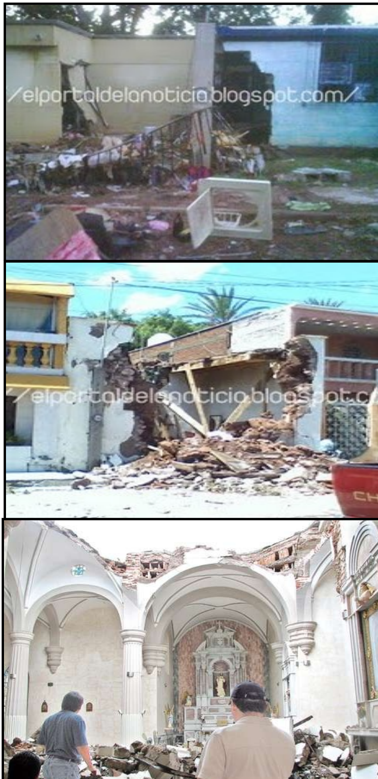
Figura 26. Daños a viviendas y construcciones antiguas.
