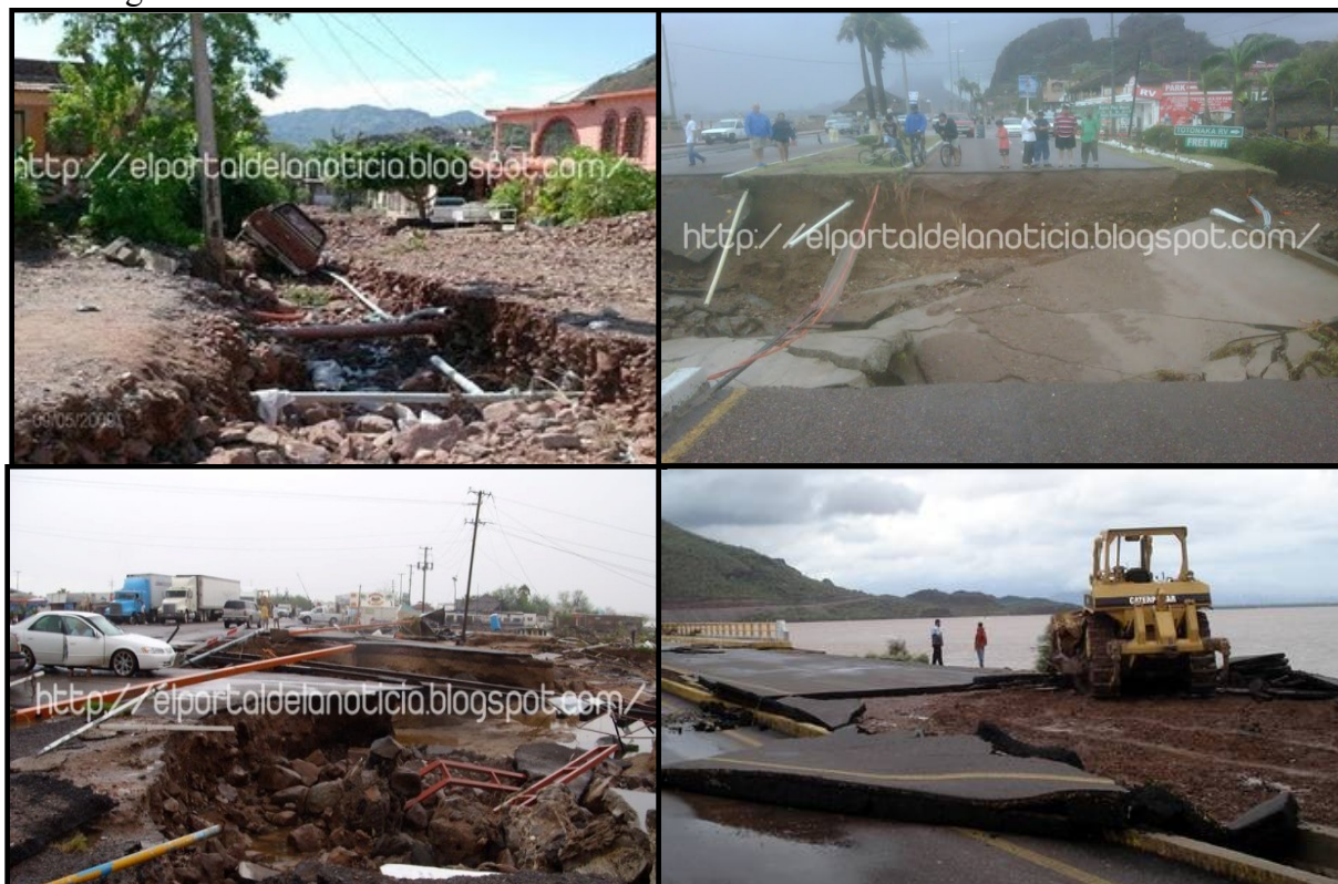
Figura 27. Daños a vías de comunicación terrestre.
