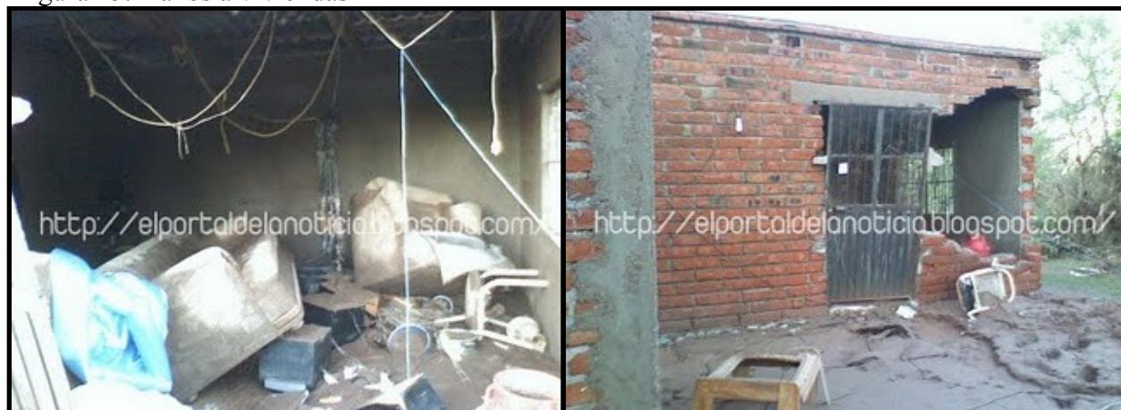
Figura 25. Daños a viviendas
