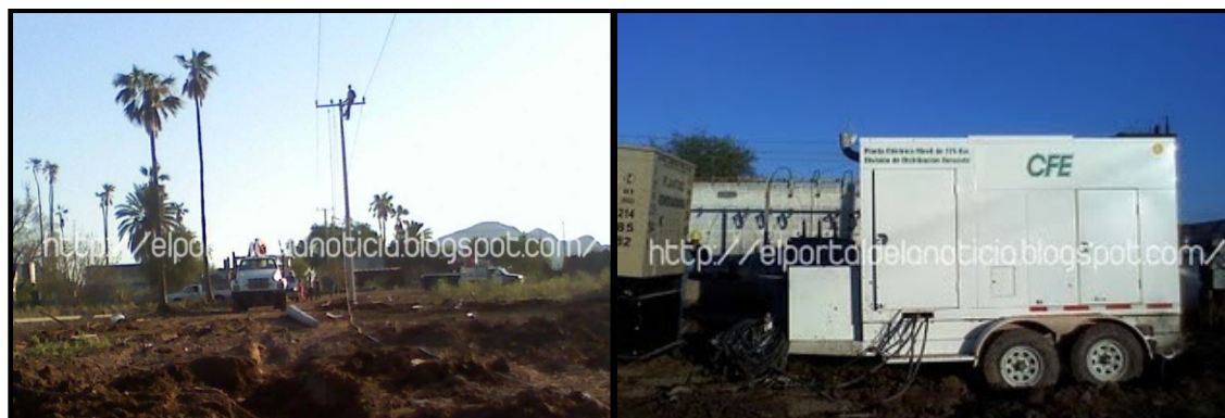
Figura 29. Obras de reparación de la CFE.
