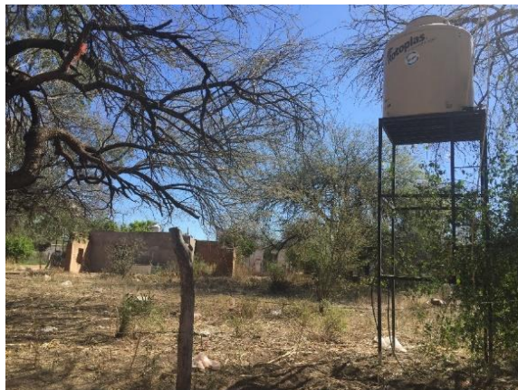
Figura 6.3 Instalación de tinaco: predio de agostadero, San Rafael de Ures
