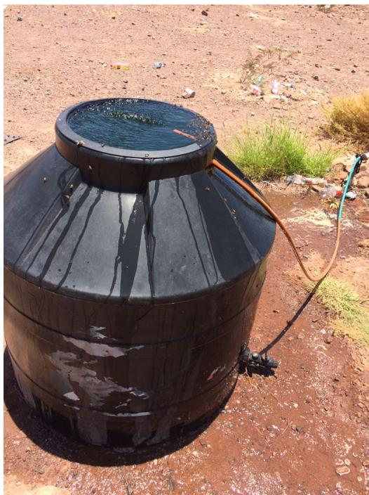
Figura 4.11 Tinaco de seiscientos litros con fuga de agua por fuera de una casa comcáac (Archivo digital entrega-recepción, Bahía Kino, 2018).
