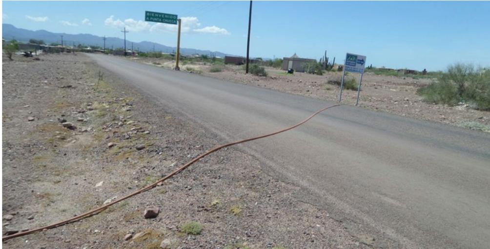
Figura 4.20 Cable “conectado” a la terminal eléctrica de la planta desalinizadora y dirigido hacia una vivienda comcáac (Archivo digital entrega-recepción, Bahía Kino, 2018).
