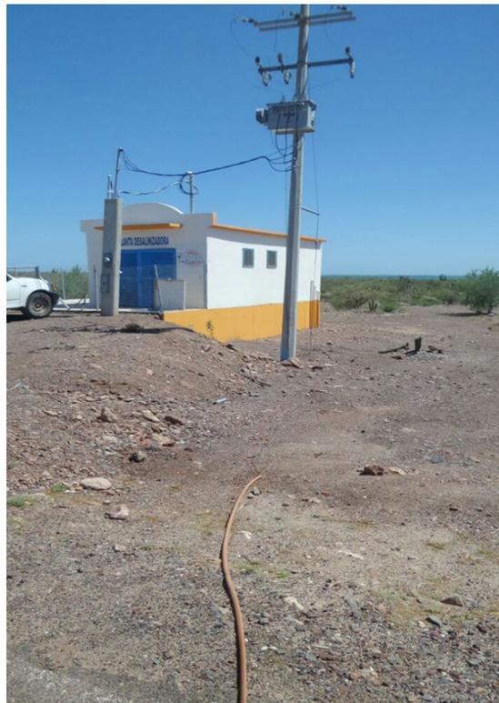
Figura 4.19 Cable conectado por un miembro de la comunidad comcáac a la terminal eléctrica de la desalinizadora (Archivo digital entrega- recepción, Bahía Kino, 2018).
