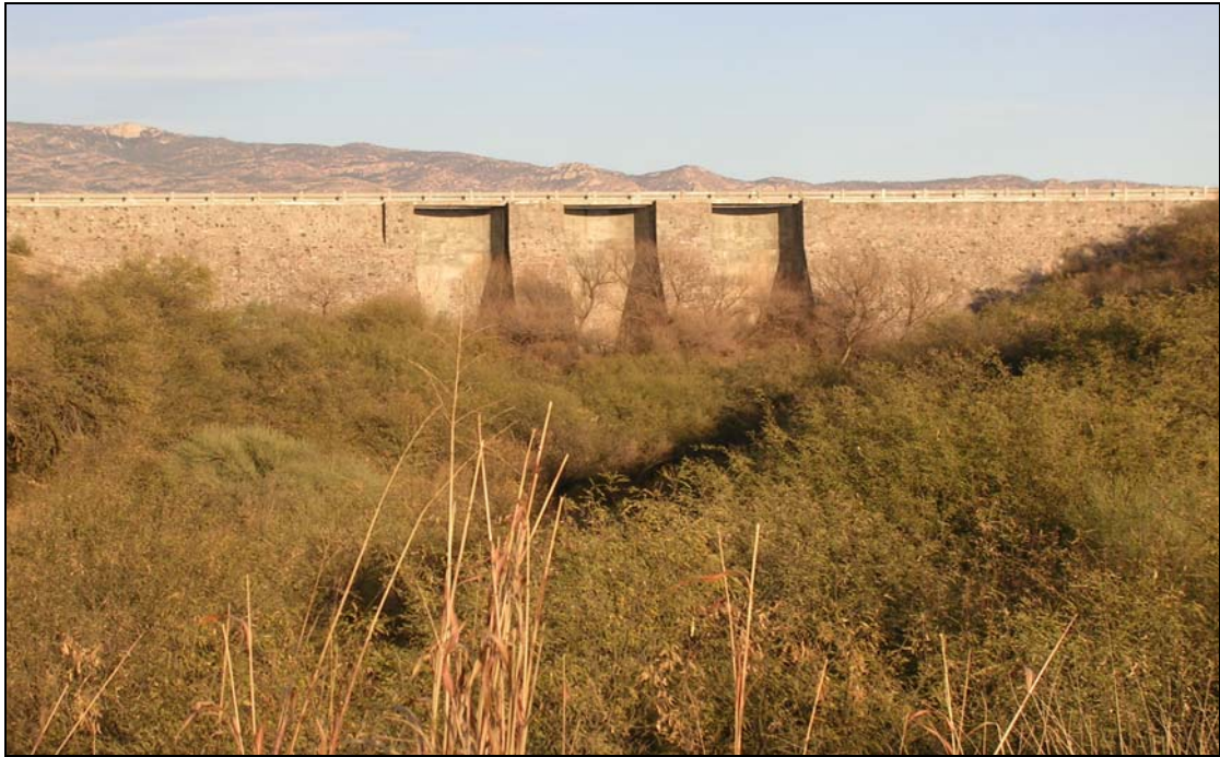
Fotografía 3. Vista del vertedero de la presa “El Yeso”, localizada en la comunidad de Magdalena de Kino, Sonora.
