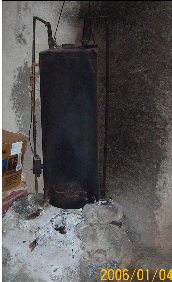
**Fotografía 3.** Tipo de tecnología para calentar agua para uso doméstico, conocido como boiler o calentón en viviendas tipificadas como “C”, en la región de Moctezuma, Sonora, México.
