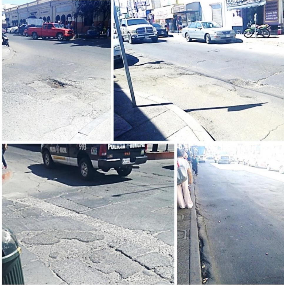
Ilustración 20. Vías dañadas y deterioro espacial en la zona de estudio, causado por el medio motorizado y la mala calidad de la construcción. Fuente: fotografías propias (2017).
