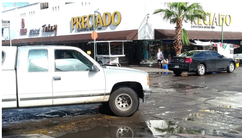
Ilustración 19. Baches y encharcamientos en el centro de Hermosillo. Fuente: fotografía propia (2017).
