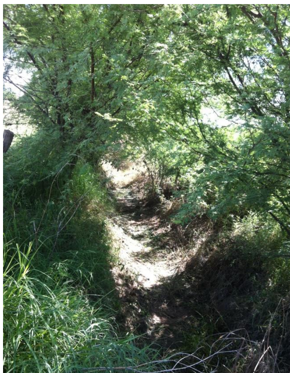
Figura 3. Canales de riego sin revestimiento de acequias en el ejido El Carmen
