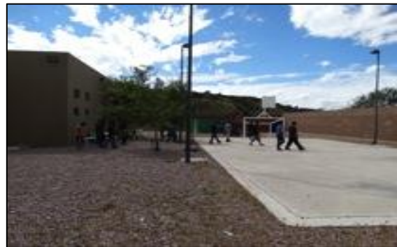
Imagen 12 Patio exterior del módulo
