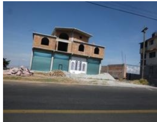
Imagen 4 Comunidad de Agostadero, Acambay, Estado de México.
