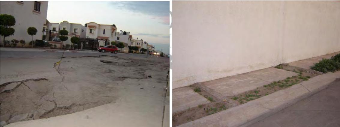
Fig. 29a y b. Izquierda (a): Hundimiento de colector de aguas negras en el fraccionamiento Villa Residencial Bonita. Derecha (b): La solución tomada por un vecindado al problema del contenedor de basura.
