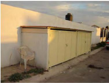
*Fig. 7 Solución a las dimensiones inadecuadas para la maniobra del camión recolector de basura (“error de diseño”): Obstrucción de banqueta por contenedor de desechos.*
