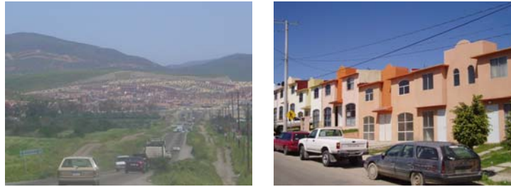
Fig. 16. y 17. Conjunto de El Refugio visto desde la carretera, se puede apreciar que se ha desarrollado en las partes bajas de los cerros y no tiene pendientes significativas (izquierda). Fachadas de las viviendas (derecha).
