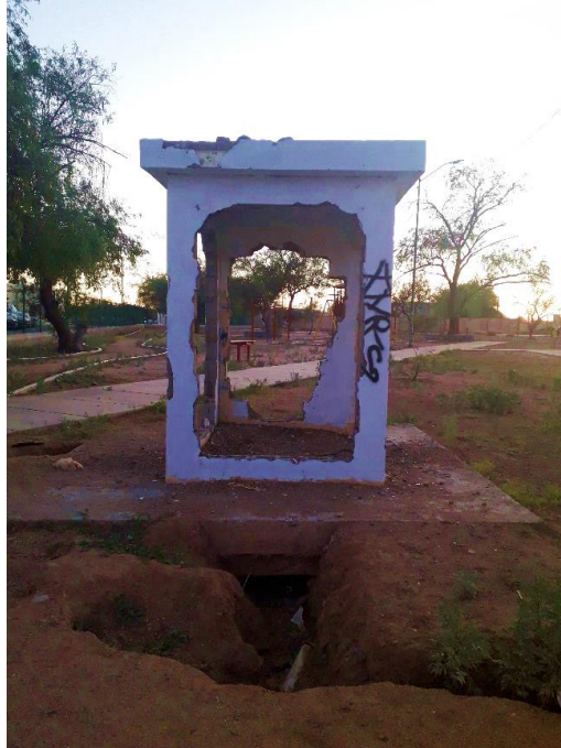
Figura 24. Edificación de posible baño
