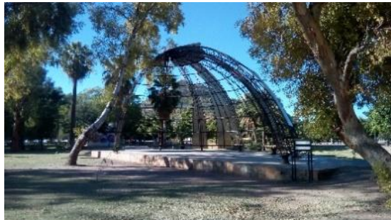
Fotografía 2 Concha acústica del Parque Madero. Foto: Adrián Nápoles.
