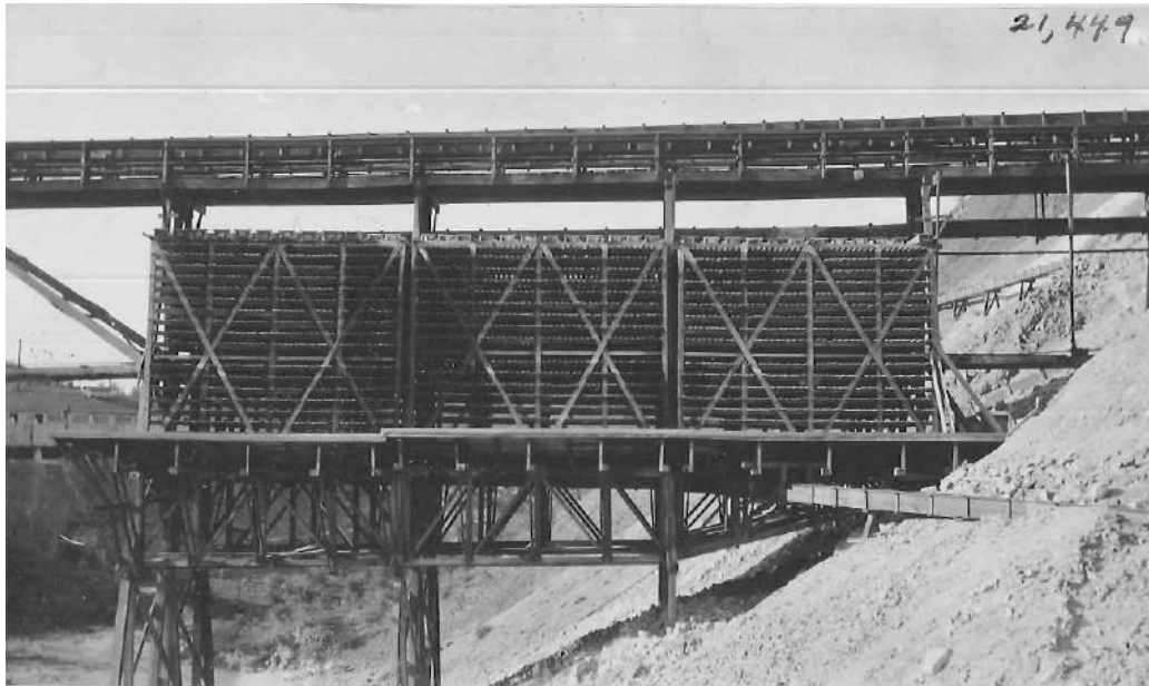
Figura VI.4: Lavadoras y enfriadores
