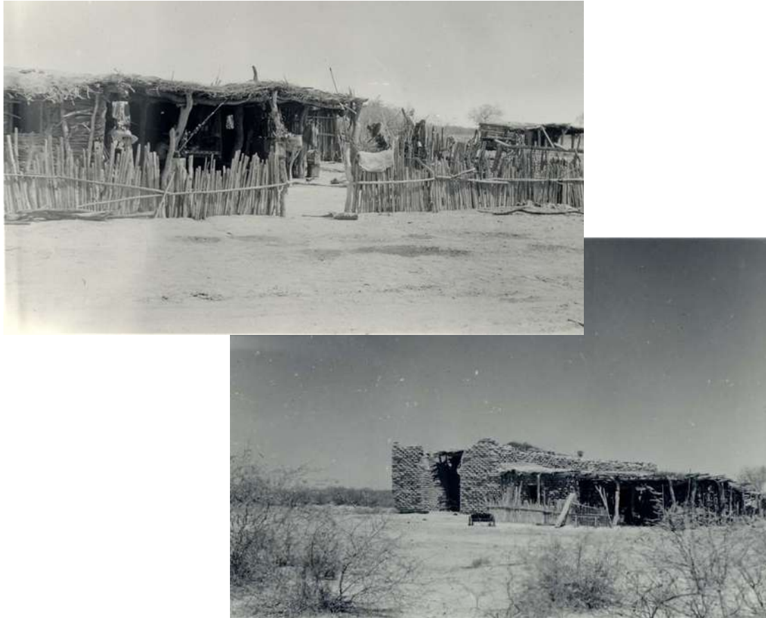
Figuras 3.4 y 3.5. Superior izquierda: casa de la familia Coronado en 1941. Inferior derecha: restos de una gran estructura de adobe
